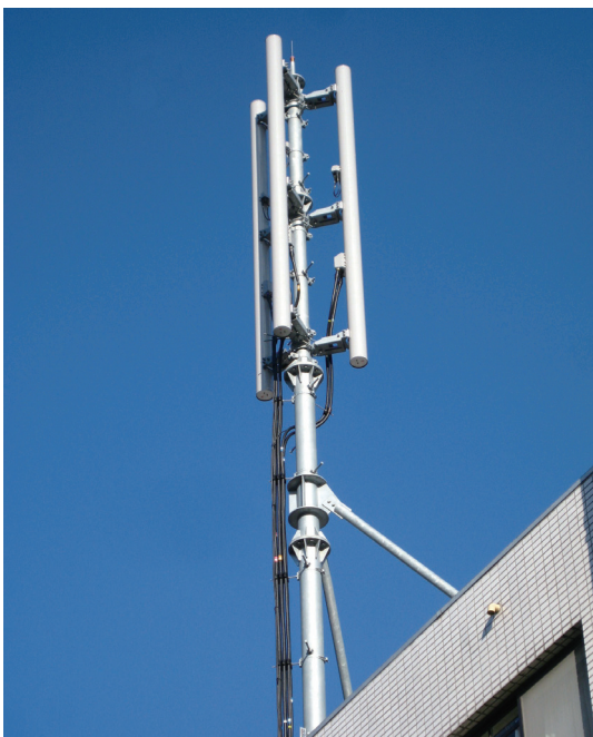
図表3 LTE 実験 基地局アンテナと検証用端末
