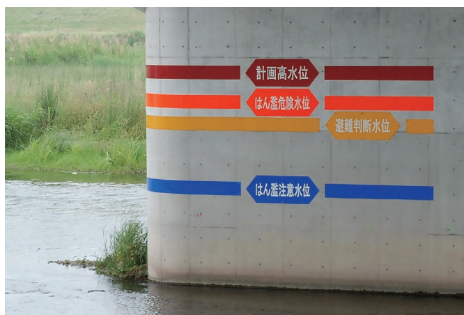
図表 4 各水位が記載された橋脚 氾濫危険水位は計画高水位より下になっている
