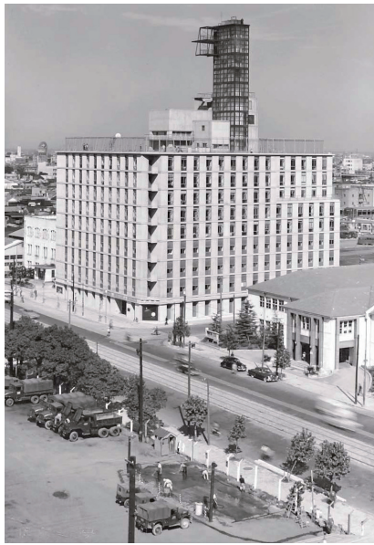
竣工当時の東京局舎
