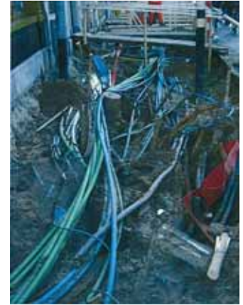
【図表 8】管路を使わず地下に直接埋設する アムステルダムのカбель敷設作業
